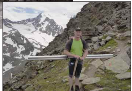
Wegebau an der Sulzenau
